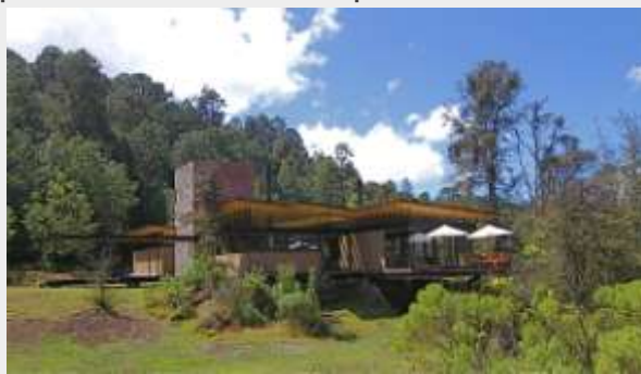
Casa Sen. Es una estructura de acero forrada de madera y vidrio, en medio de un bosque.
